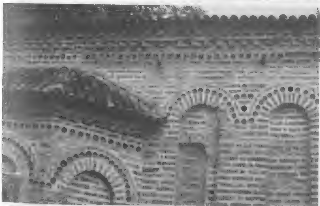
Котляна, Влашко, между Крайова и Питеш. Манастирска църква от 1370–1380 г., построена в стила на търновските църкви. Църквата в Котляна дава представа, как са изглеждали много от църквите в старата българска столица, преди да почнат да се рушат: прости и груби, украсата е ограничена до плиткни ниши и редове глазиранни панички, подчертаващи линиите. Църквата в Котляна дава по-добра представа, как трябва да изглежда една българска постройка от XIV в., отколкото търновските църкви, развалени от наскорошната „реставрация“. Скулптурният прозорец на апсидата е добавка от XVIII в. в стила на периода Брънковяну.
